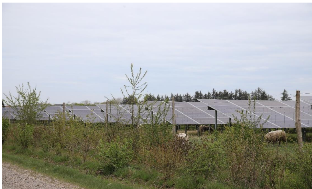
Figur 7.10 - Foto af solcellepark et par år efter etablering af beplantningsbælte
