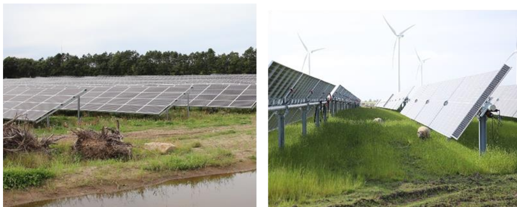
Figur 2.5 -Solceller monteret på faste stativer (til venstre) og på bevægelige stativer, kaldt trackersystem (til højre).
