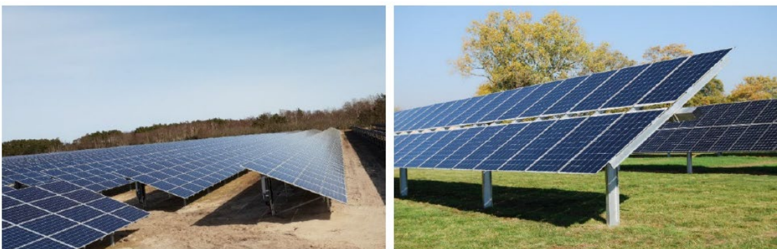
Figur 4: Solceller monteret på faste stativer (til venstre) og solceller monteret med trackersystem (til højre).
